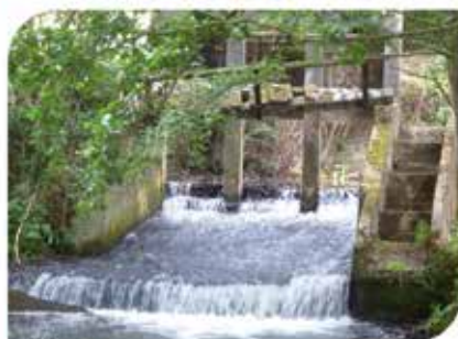
Vannage et passe à poissons avant travaux
